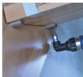
Die Stufen werden komfortabel von unten festgeschraubt
