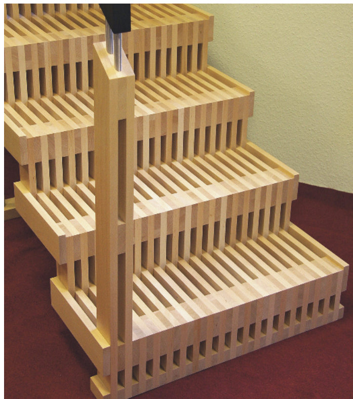
Falwerkriegeltreppe von Tischlermeister Markus Kynast
