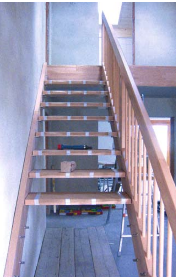
Bei der Montage wird mit der mittleren Stufe begonnen
