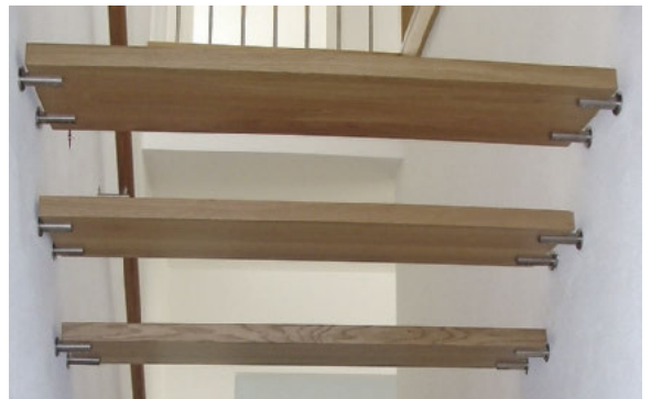
/ Bei der Montage werden die Treppenstufen einfach von oben auf vier Verbinder gelegt und von unten verschraubt.
