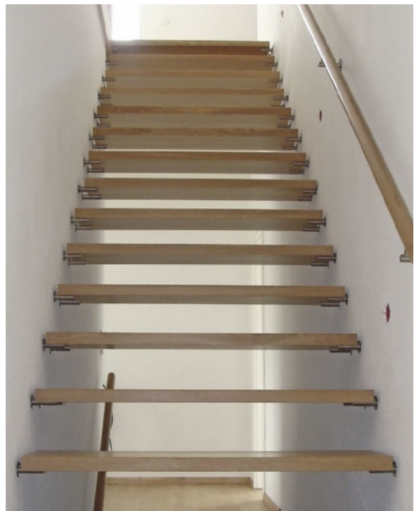
/ Der Beschlag von Kreuzberger erlaubt auch die einfache Montage schwebender Trittstufen zwischen zwei Betonwänden.
