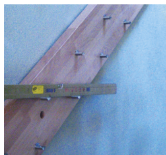
Zuerst werden die Wangen gesetzt und dabei exakt ausgerichtet
