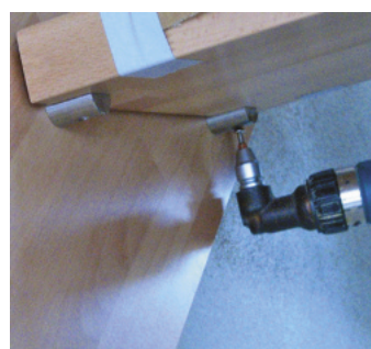
Die Stufen werden komfortabel von unten festgeschraubt
